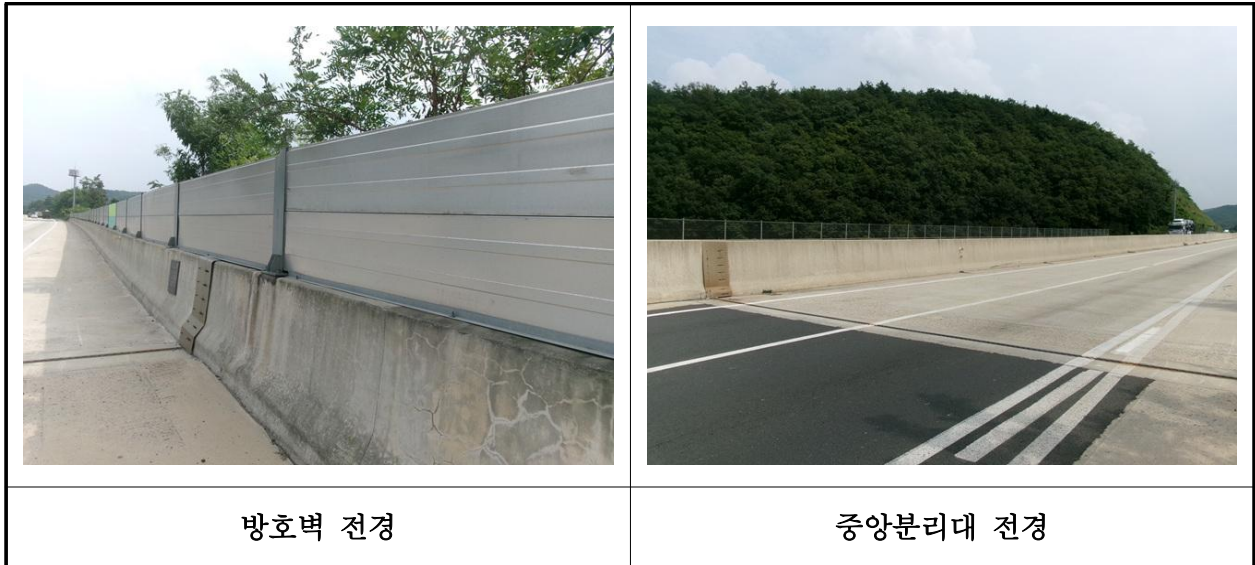
【사진 23.3.48】 방호벽 및 중앙분리대 전경
