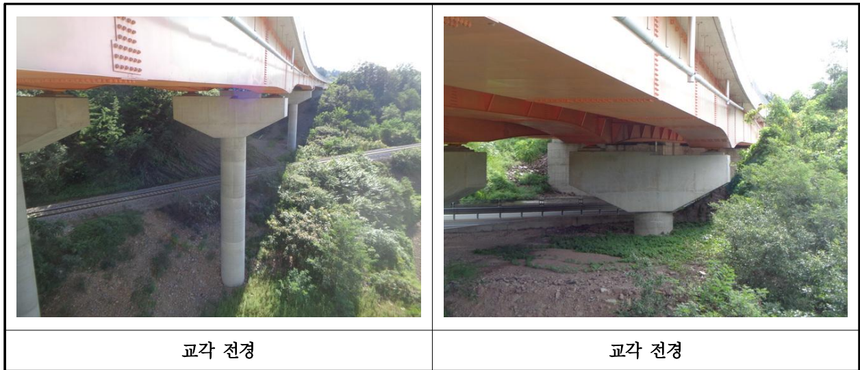
【사진 23.3.35】 교각 전경
