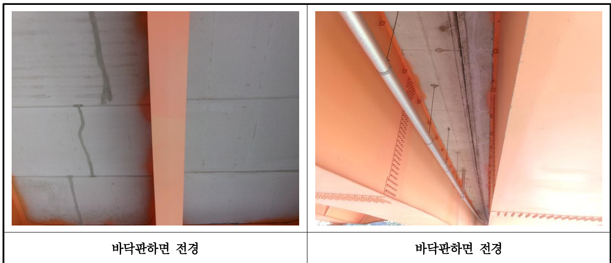
【사진 23.3.27】 바닥판하면 전경
