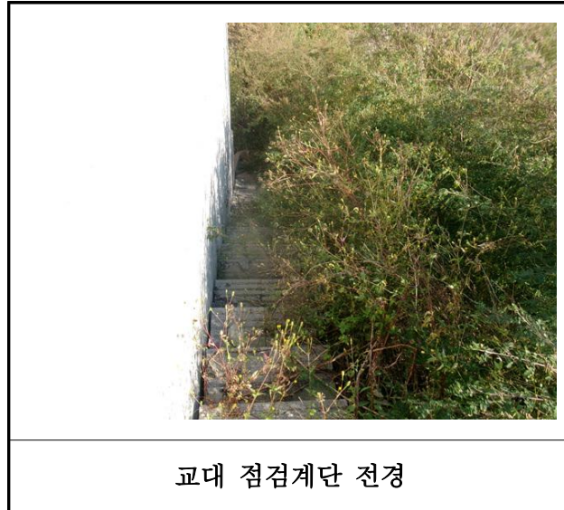
【사진 23.3.50】 교량 점검시설 전경
