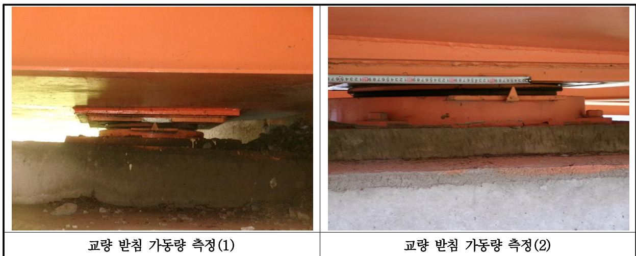
【사진 23.3.15】교량받침 이동량 측정
