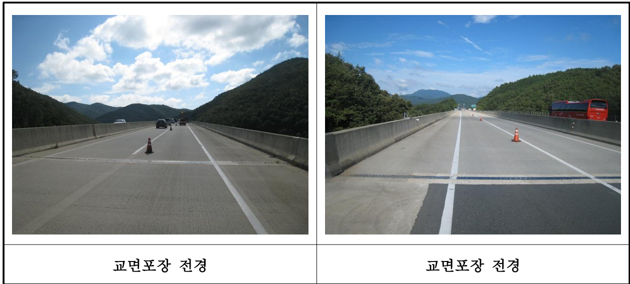
【사진 23.3.44】 교면포장 전경
