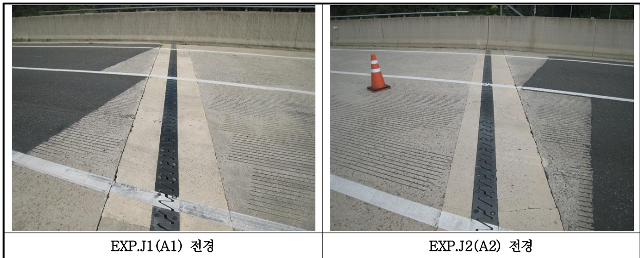
【사진 23.3.41】 신축이음장치 전경
