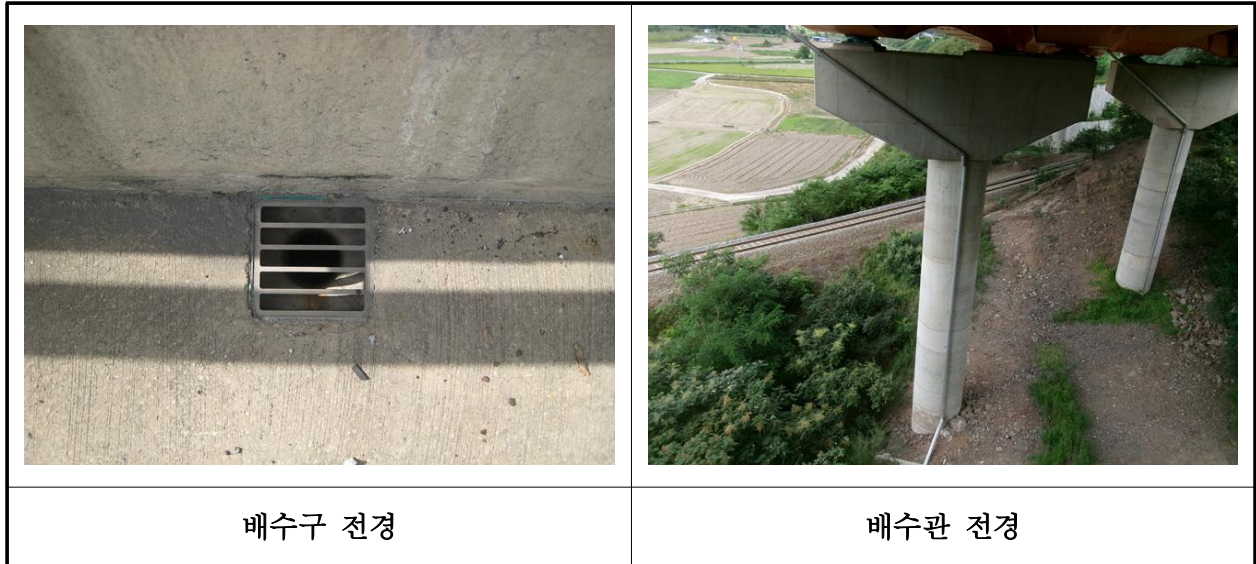
【사진 23.3.46】 배수시설 전경
