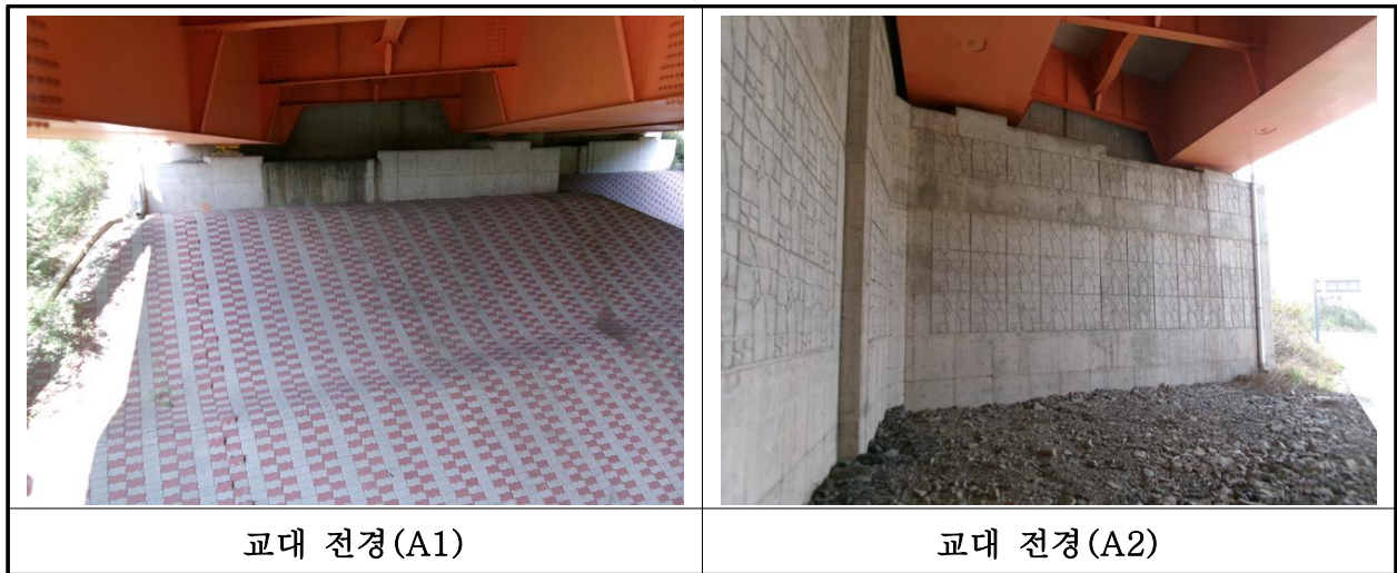
【사진 23.3.33】 교대 전경
