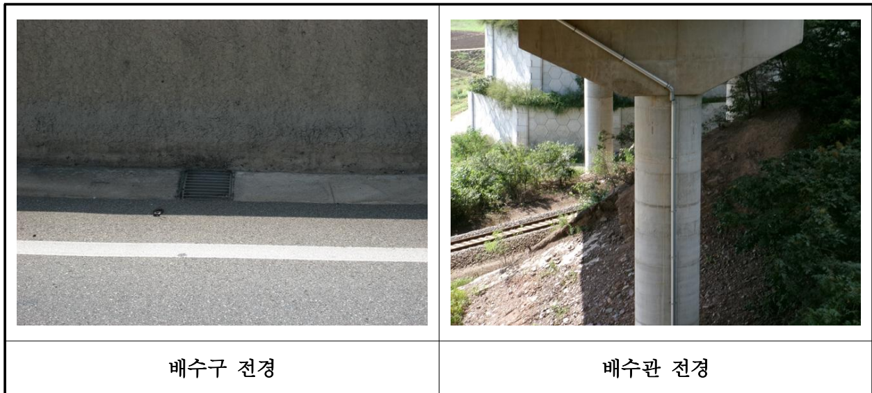
【사진 23.3.21】 배수시설 전경
