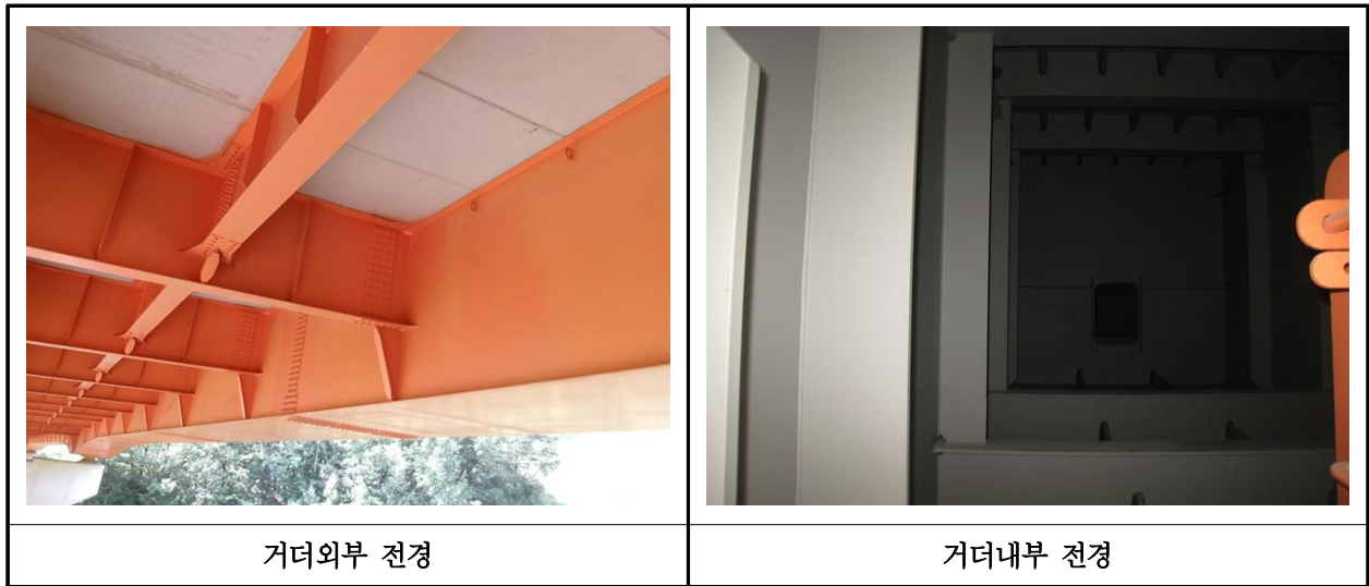
【사진 23.3.4】 거더 전경
