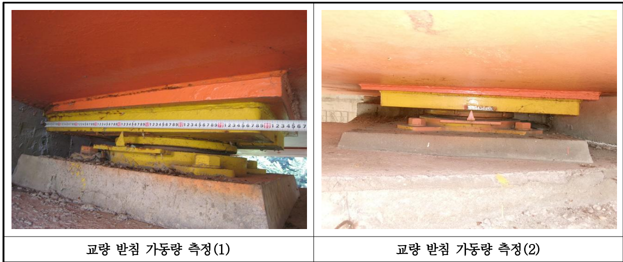
【사진 24.3.40】 교량받침 이동량 측정
