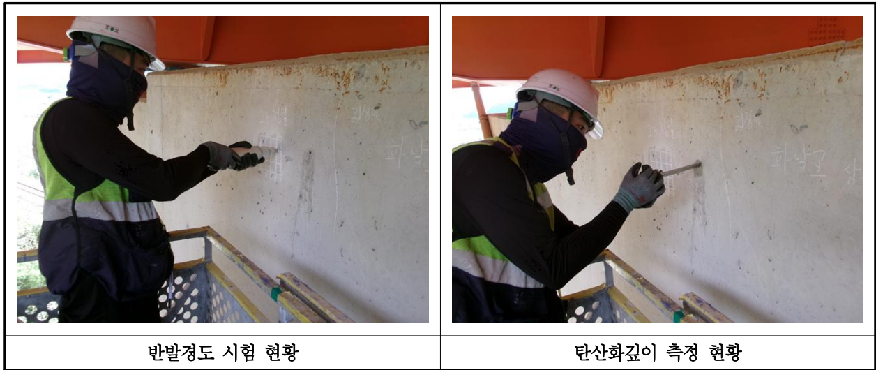
【사진 23.4.1】 콘크리트 내구성조사 현황
