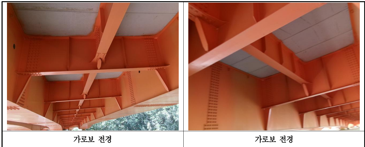
【사진 23.3.6】 가로보 및 세로보 전경
