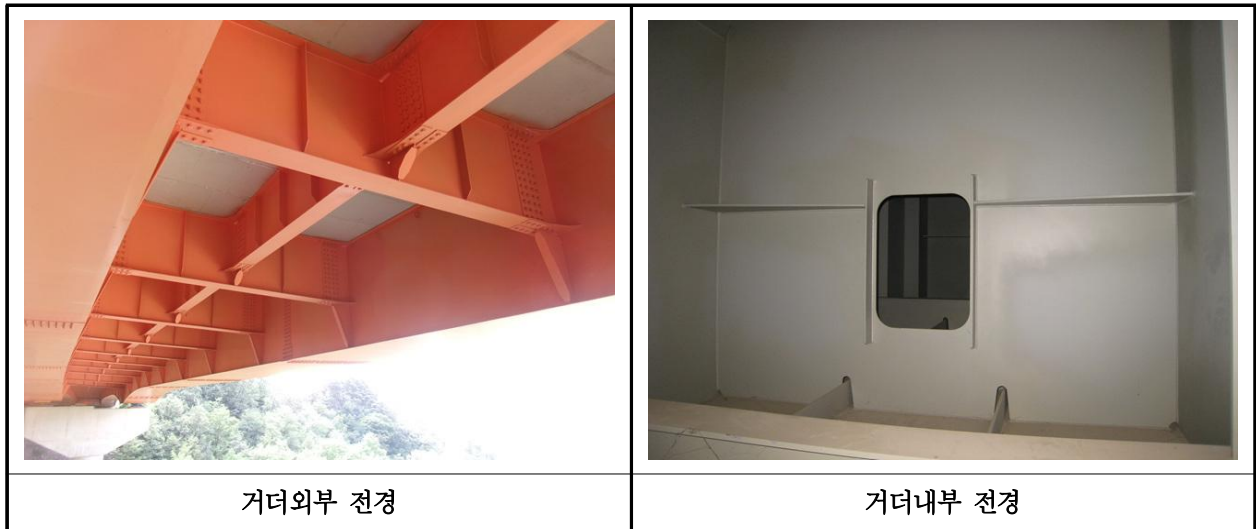
【사진 23.3.29】 거더 전경
