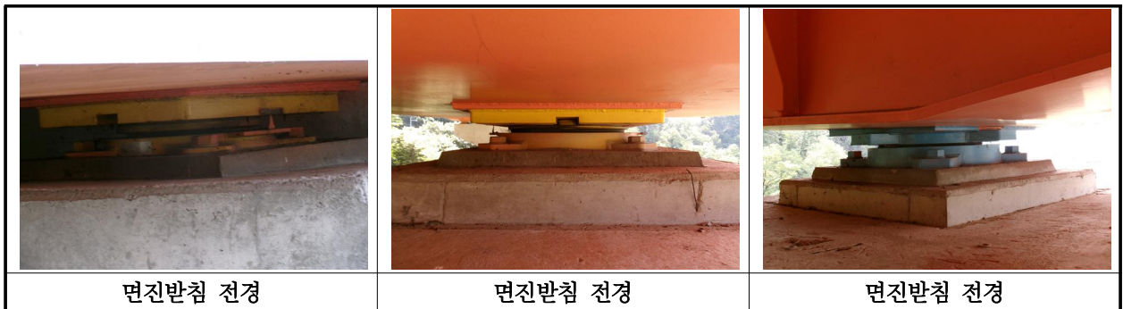
【사진 23.3.37】 교량반침 전경
