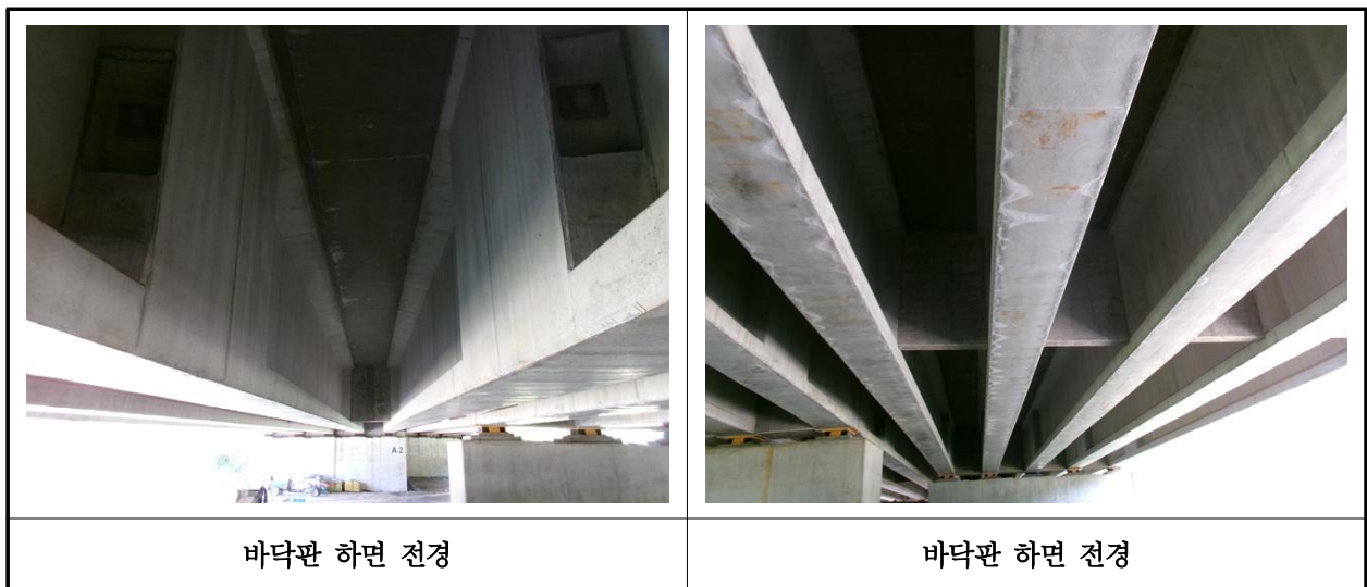
【사진 23.3.2】 바닥판하면 전경
