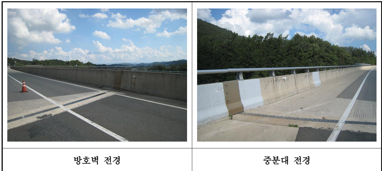
【사진 23.3.23】 방호벽 및 중앙분리대 전경
